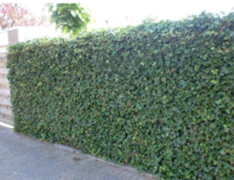
gaashekwerk met bovenbuis h=2000mm v.v. klimplant, type i.o.m. gemeente
