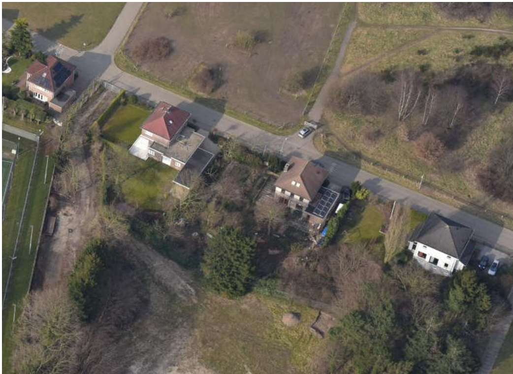
Bovenaanzicht van de woningen aan de Ubbergseveldweg 136, 138, 140 en 142, bron: [REDACTED]
