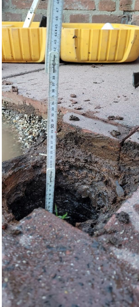
Figuur 4 vermoedelijke opbouwhoogte vanaf (beton)dek tot bovenzijde tegel is ca. 30 cm.
