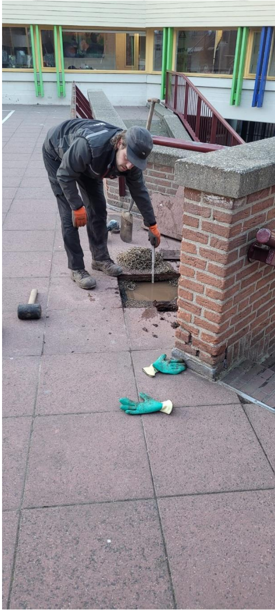
Figuur 3 het hemelwater stroomt door de split laag richting het laagste deel van het dak en blijft daar staan. Overtollig water zal over moeten stromen.
