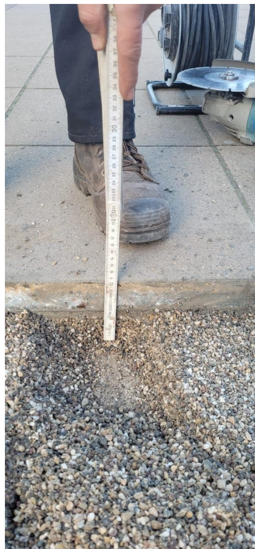
Figuur 2 opbouwhoogte vanaf dakbedekking tot bovenzijde tegel is ca. 10 cm. Dit is gemeten op het hoogste punt van het schoolplein.
