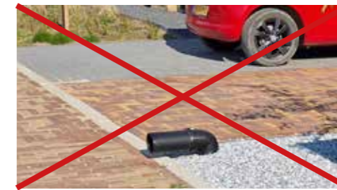
Ref. 3.1 Afwatering via buis niet toegestaan
