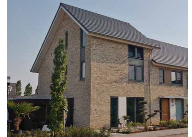
Ref. 3.29 Verbijzondering hoekoplossing d.m.v. verspringing van de gootlijn
