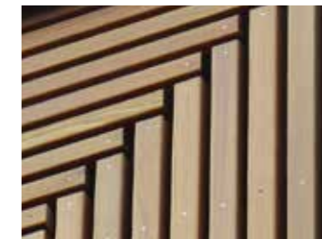
Ref. 3.53 Detaillering in houtverwerking, variatie aan breedte van planken, horizontaal vs. verticaal, reliëf
