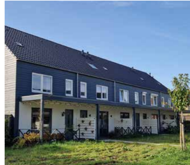
Ref. 3.37 Veranda's aan het park
