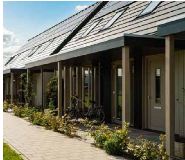
Ref. 3.36 Veranda's aan het park
