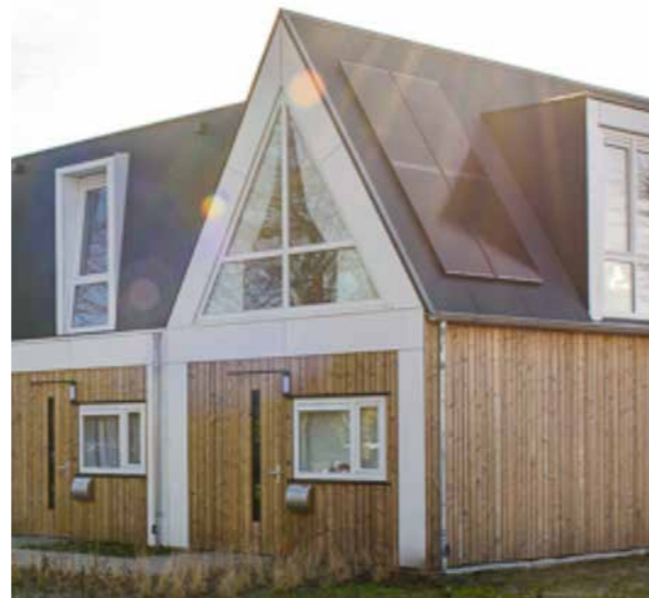
Ref. 3.25 en 3.26 Verbijzondering hoekoplossing d.m.v. verdraaiing van de kaprichting
