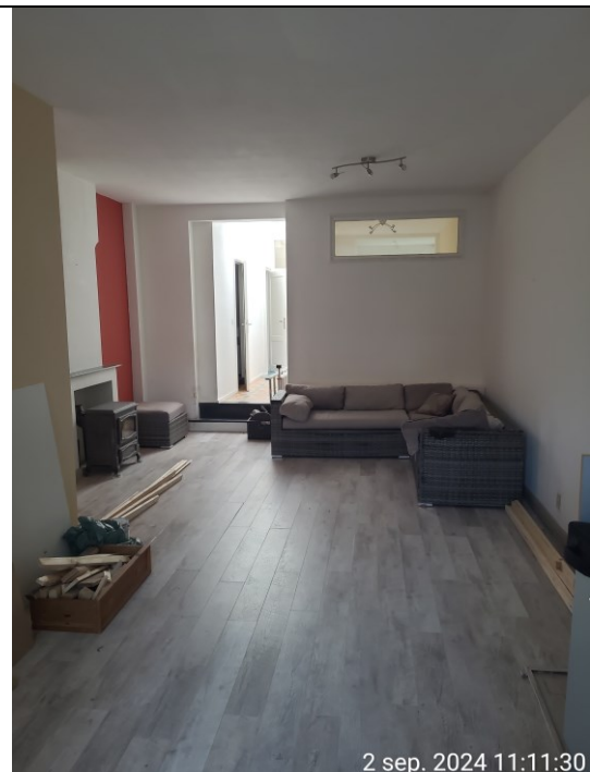
Foto kamer genomen richting achterzijde woning. Geen Rookmelder aanwezig
