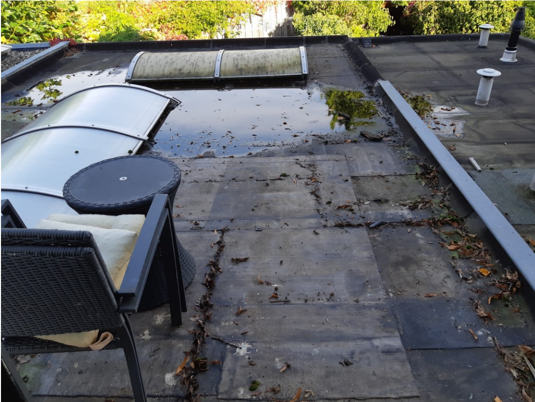
Het dakterras is verwijderd
