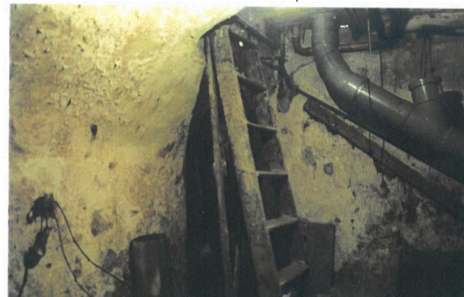
Foto 01 van het bestaande rioleringsverloop (standleiding) in de bestaande kelder, zicht van de zuidoost wand kelder (Bron: Bouw Historisch Onderzoek, Monumenten Advies Bureau)
