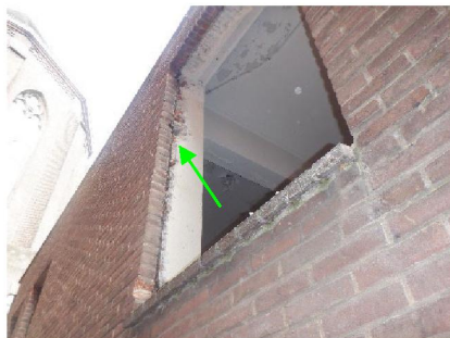
Aanzicht bitumen, monster 3 en 4 en bitumen, in spouwmuren rondom kozijn magazijn
