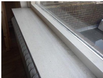
Aanzicht beglazingskitten en versterken achtergevel bovenwoningen
