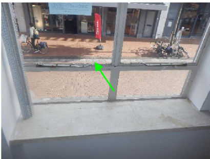
Aanzicht kit, monster 1 en 2 en kit, kozijnen voorgevel bovenwoningen
