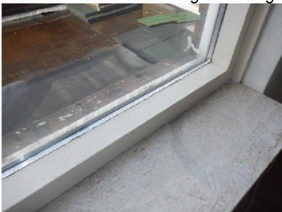
Aanzicht beglazingskitten en versterken achtergevel bovenwoningen
