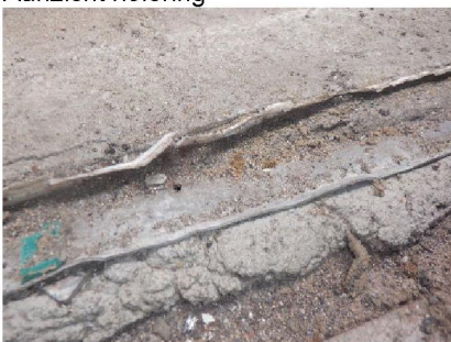
Aanzicht verloren bekisting en leidingen met isolatie
