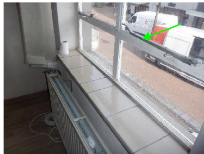
Aanzicht kit, monster 1 en 2 en kit, kozijnen voorgevel bovenwoningen
