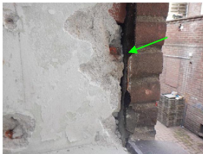
Aanzicht bitumen, monster 3 en 4 en bitumen, in spouwmuren rondom kozijn magazijn
