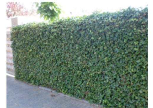
— gaashekwerk met bovenbuis h=2000mm v.v. klimplant, type i.o.m. gemeente
