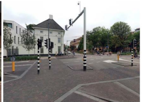
Niet goed herkenbare oversteek door ontbreken van markering
