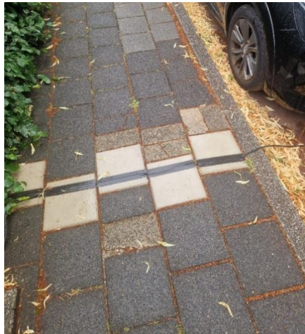
Figuur X: Kabelgoot (eigen afbeelding)
